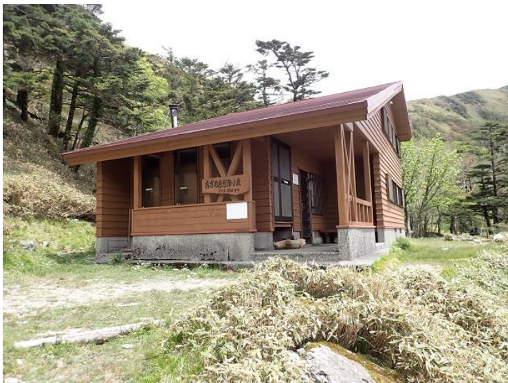
・お亀岩避難小屋到着
